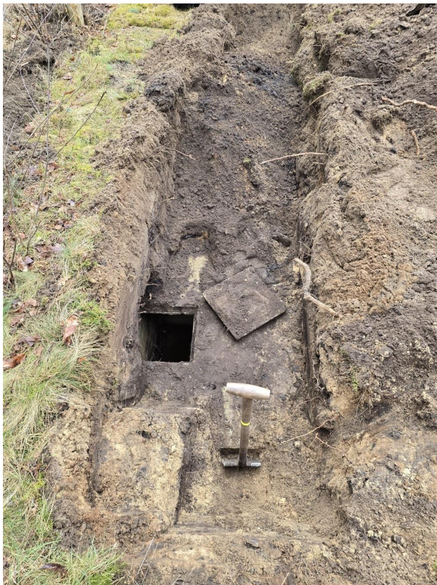
Figuur 6 – Zicht op de (geopende) aangetroffen septic-tank.
